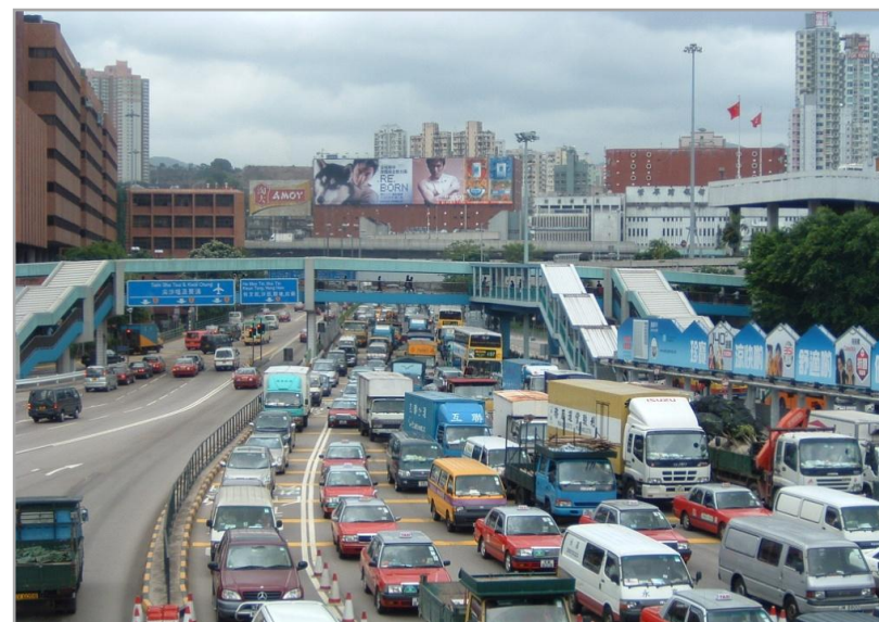
海底隧道入口（往港島方向）
