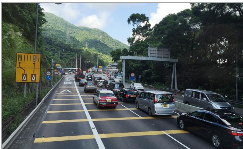
獅子山隧道入口（往九龍方向）
